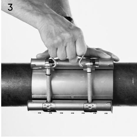
Verschluss einhaken. Schrauben abwechselnd und gleichmässig anziehen.
